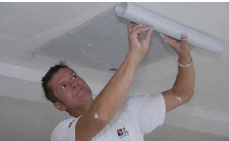
Überkopfauftrag bei der Deckenheizung im Wohnzimmer.
