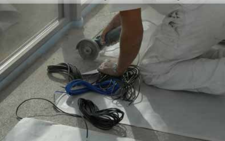
Es werden die Vertiefungen für die Stromkabel geschlitzt.
