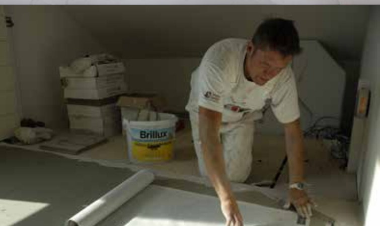
Ausrollen der hicoTHERM®-Folie im Mörtelbett.
