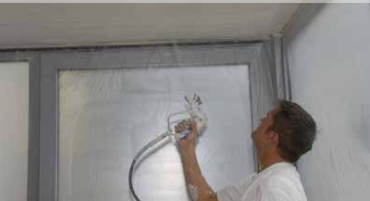
Der Deckputz wird einfach aufgespritzt.
