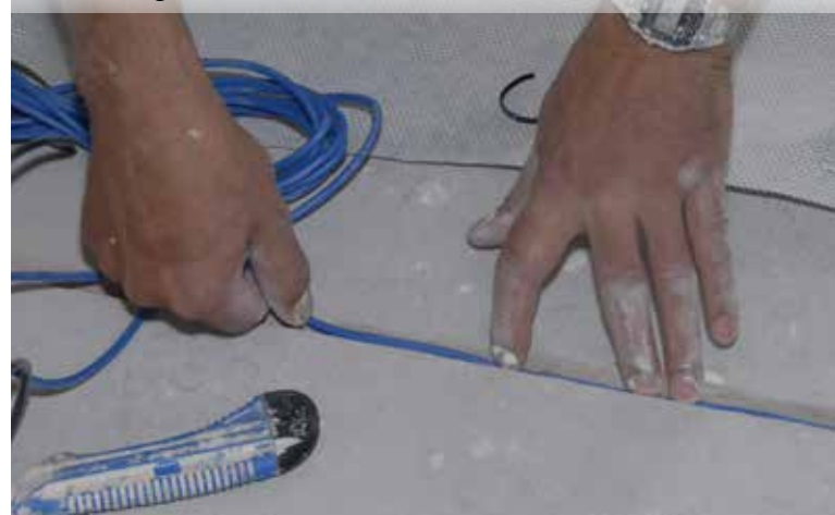
Verlegen der Stromkabel.
