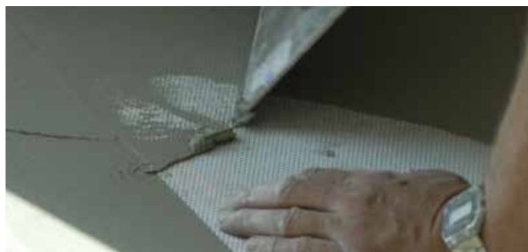
Mit der Glattkelle wird die Heizfolie in den Fliesenmörtel gedrückt und der Mörtel glatt abgezogen.
