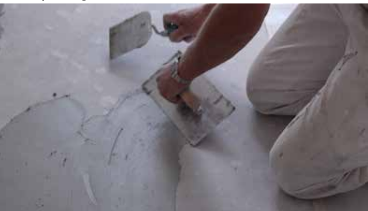
Mit der Glattkelle wird der mineralische Dünnbettmörtel auf den Boden aufgetragen.
