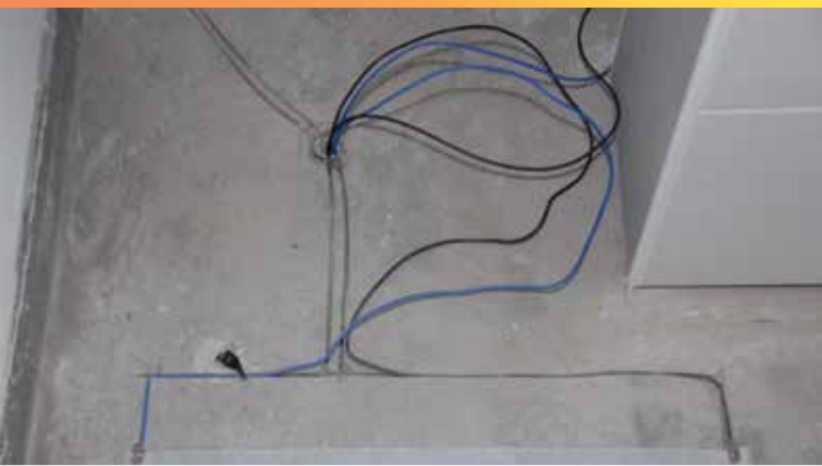
Die Elektriker von Elektroservice Kämmer führten die Kabel dann zum Trafo.
