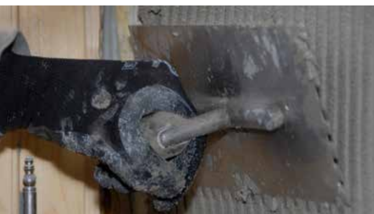
Der mineralische Mörtel wird mit der Zahnkelle auf den Untergrund aufgetragen
