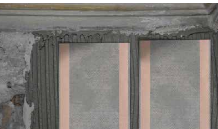
Die Heizfolie wird erst leicht auf das Mörtelbett gedrückt und ist so fixiert.
