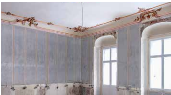
Wattleauzimmer nach der Verlegung der Heizfolie. Der farbige Stuck an der Decke ist schon wiederhergestellt, hicoTHERM wird unter der wieder eingebauten farbigen Holzpaneelverkleidung, unsichtbar sein.
