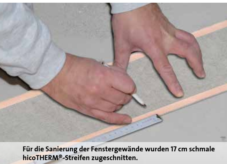
Die kritischen Wandbereiche entlang der Fensterrahmen und im Eckbereich der Laibung werden mit hicoTHERM®-Streifen ausgerüstet.
